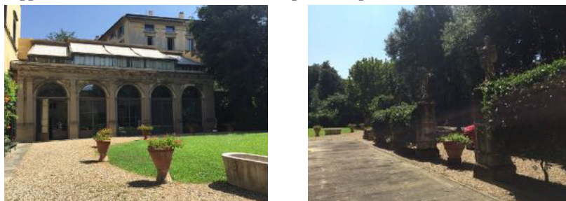
Figg. 2-3 Palazzo Pandolfini, le serre, ingresso al giardino e statue
